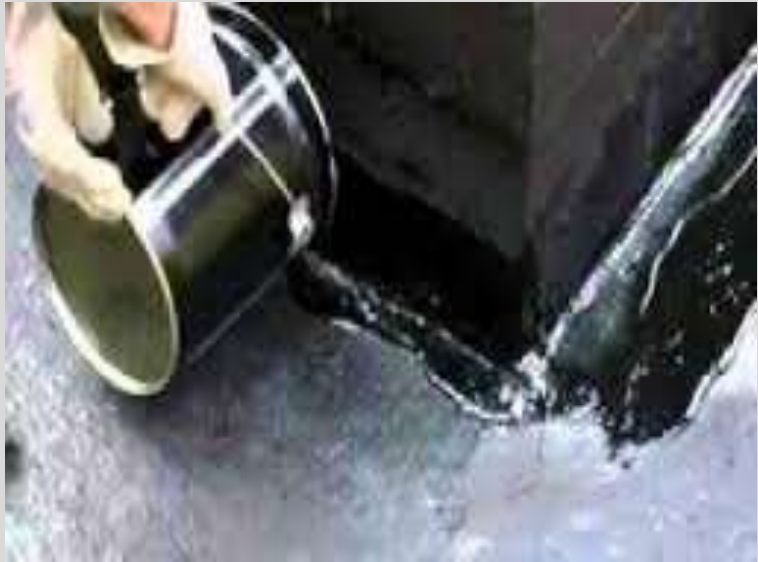
Sarok kikenése Bituthene® lemez felhelyezése előtt
